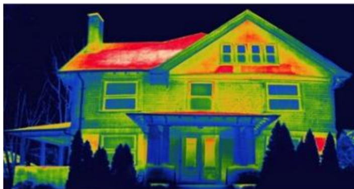
Obr. 44 Termovizní měření tepelných ztrát (zdroj: Elogy s.r.o.)
